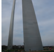
セントルイスのアーチ。来年初に完成から50周年を迎えるのを機に、周辺整備を含めた大規模な改修工事が行われる
